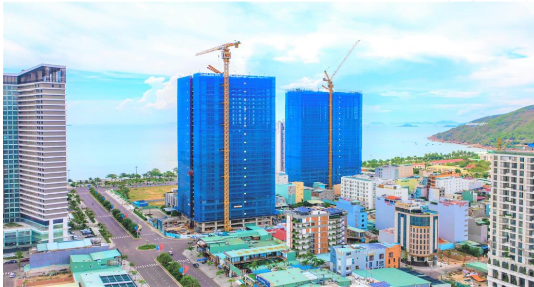
Block Flamenco và block Tropical đã hoàn thiện phần thô
