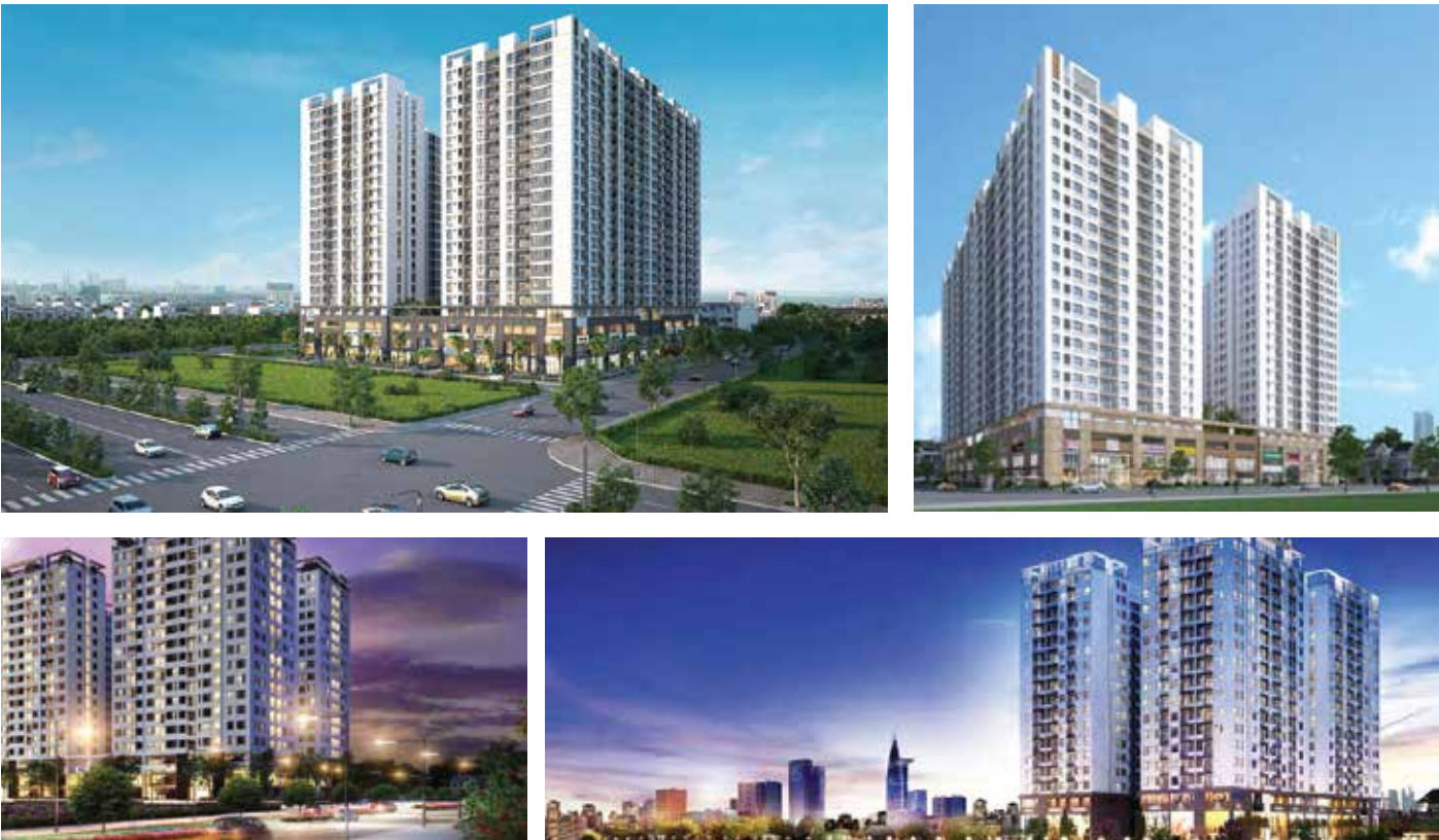
Công trình “Q7 Boulevard”
